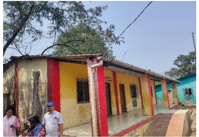
RRWHS at Sashtekar Pada School
